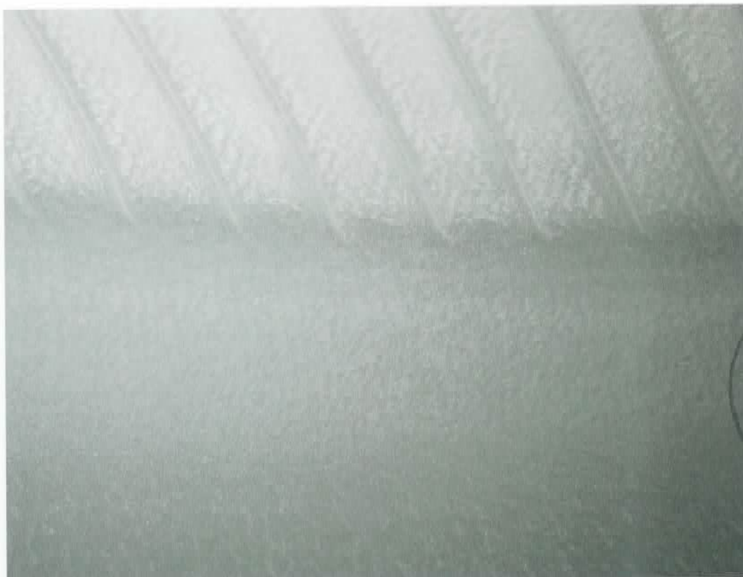
Klare Struktur im Seitenwandbereich ohne Rissbildung oder Verschleiß
